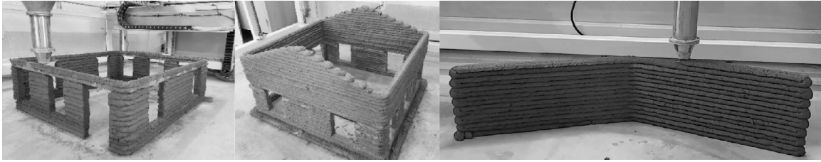
Hình 6. Quá trình xây dựng biệt thự thu nhỏ tỉ lệ 1:20 bằng máy in bê tông
