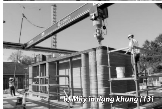
Hình 2. Thi công in nhà.
